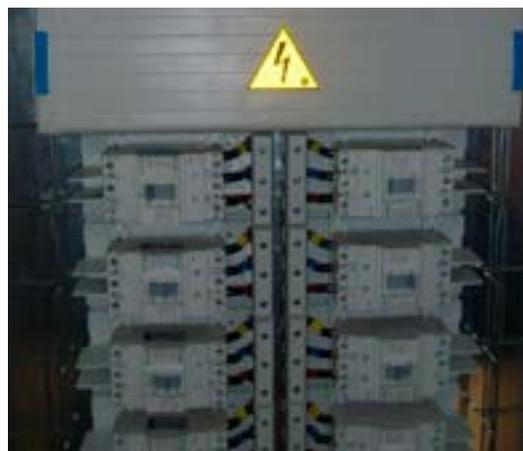
Componentes que cumplen requisitos para la elaboración de un diseño según la norma IEC/EN 61439-1
